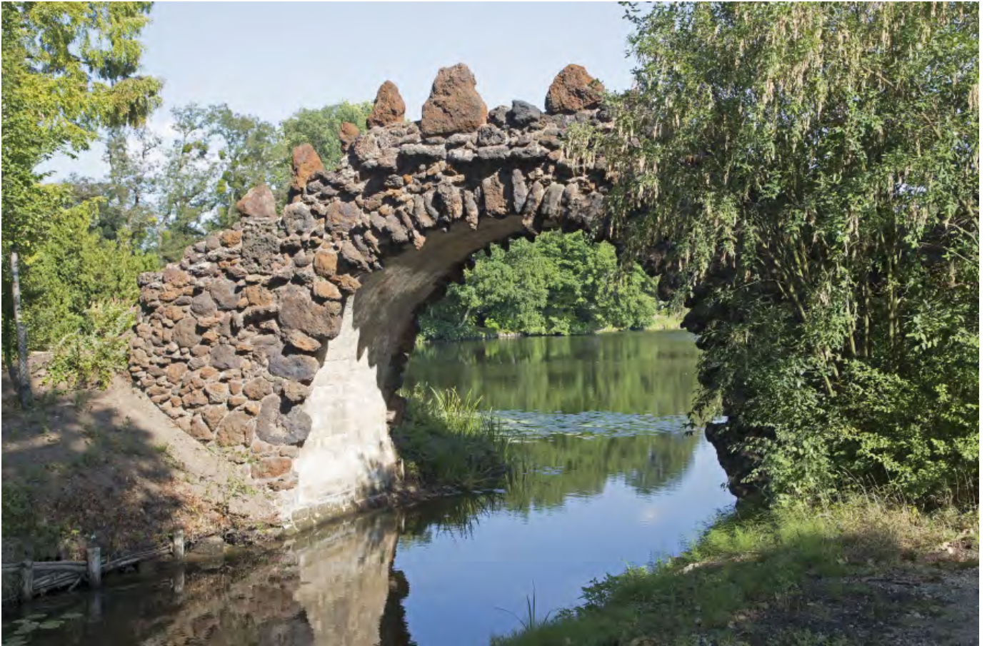
Dieses Bild entspricht dem Bild Seite 2 mit der eingerüsteten Brücke.
