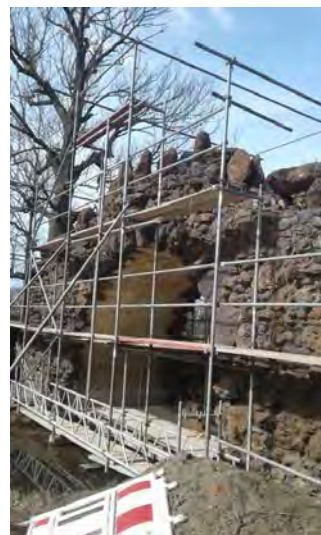
Drei Bilder von den Sanierungsarbeiten im Jahr 2018
