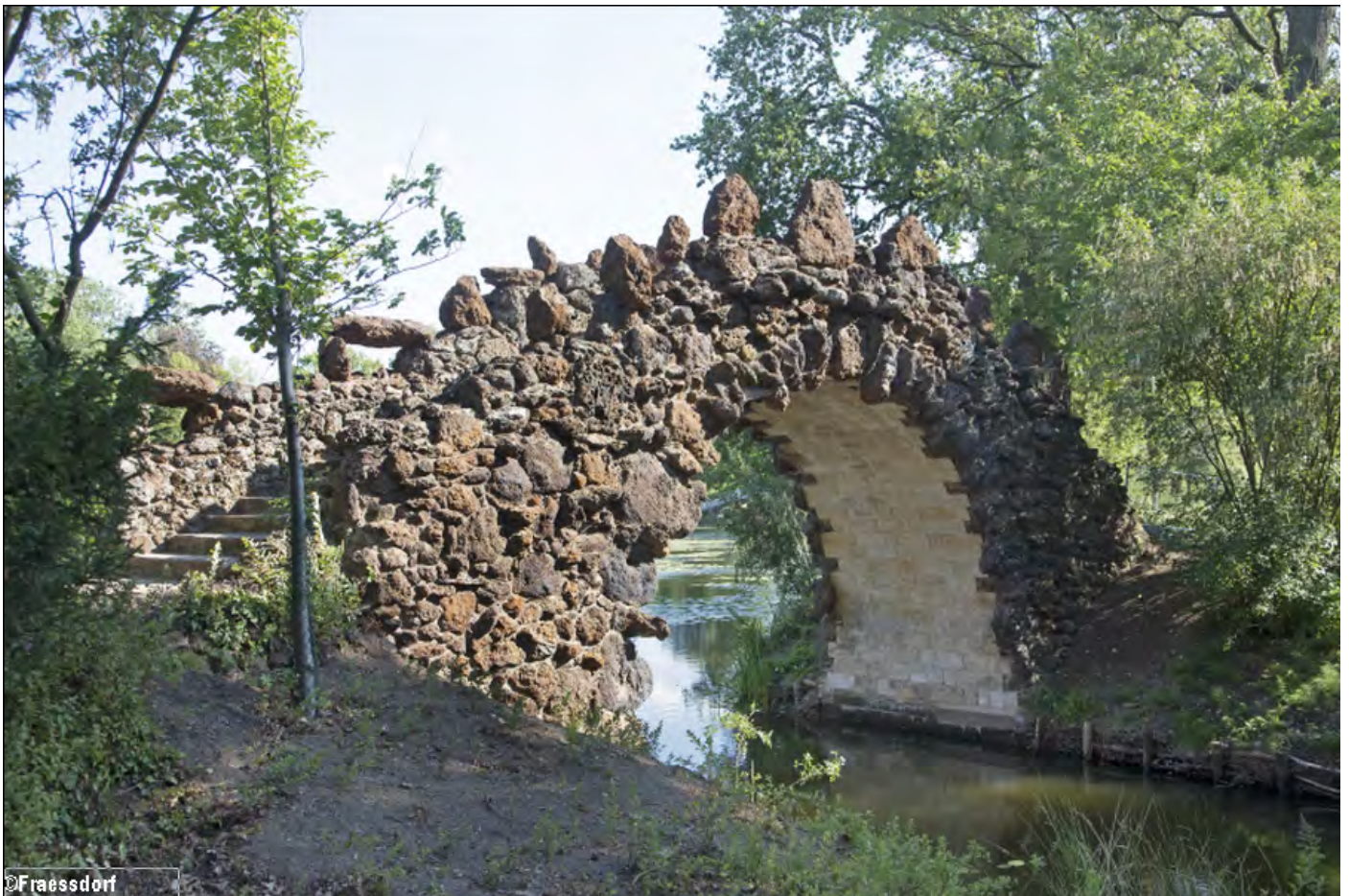
Die sanierte Brücke
