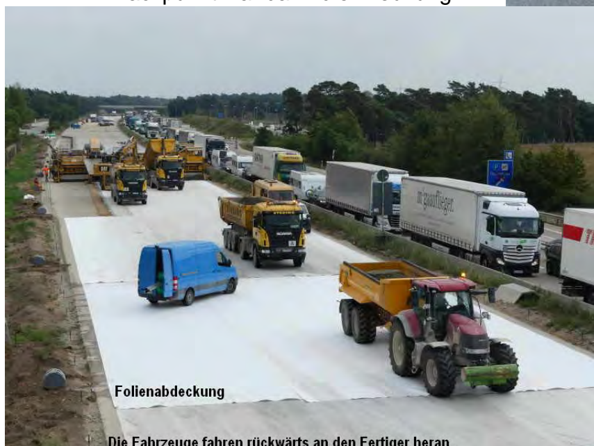
Die Fahrzeuge fahren rückwärts an den Fertiger heran.
